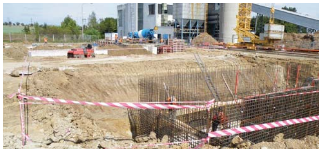
Stav na staveništi v září 2009
