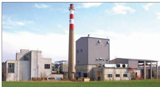
Vlevo uhelná kotelná, vpravo ORC
