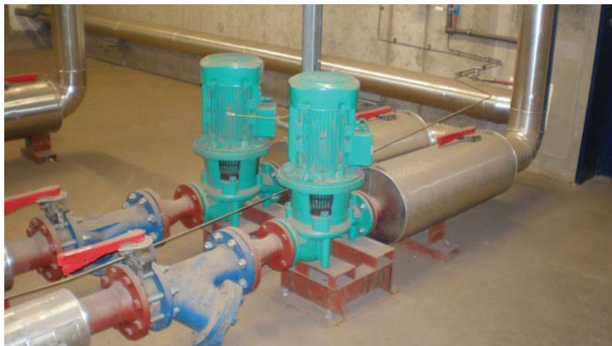
Paralelně instalovaná čerpadla Wilo-IL
