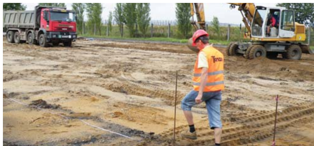
Zahájení výstavby - srpen 2009
