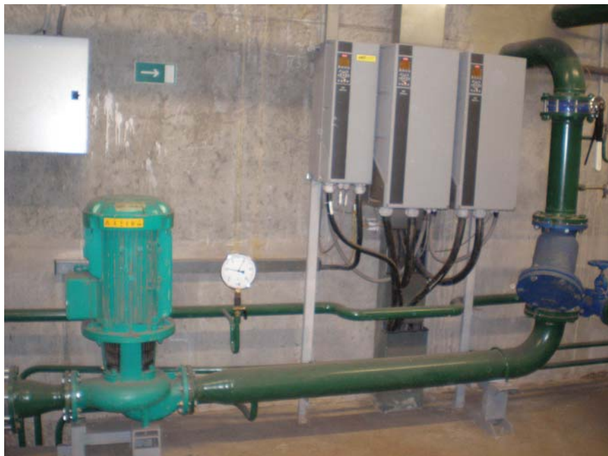
Externí frekvenční měniče Danfoss pro plynulé řízení otáček čerpadel Wilo
