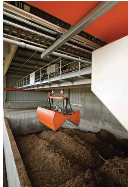
Mostový manipulátor paliva
