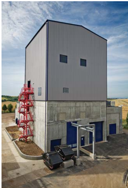
Pohled na novou kogenerační teplárnu
