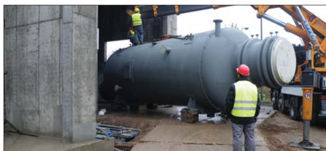
Snímek z listopadu 2009 - montáž kondenzátoru
