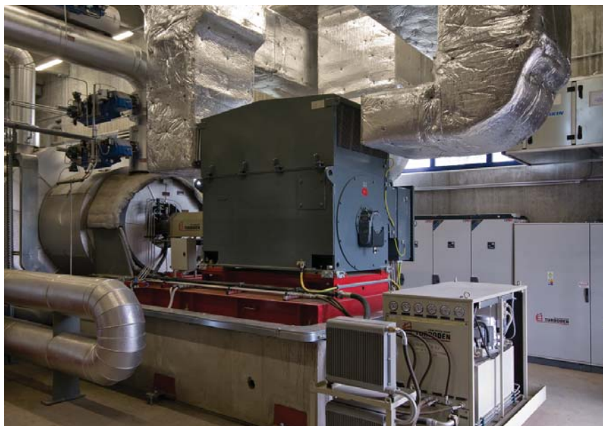
Soustrojí turbíny a generátoru
