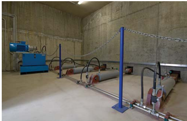
Posuvná podlaha – hydraulická část
