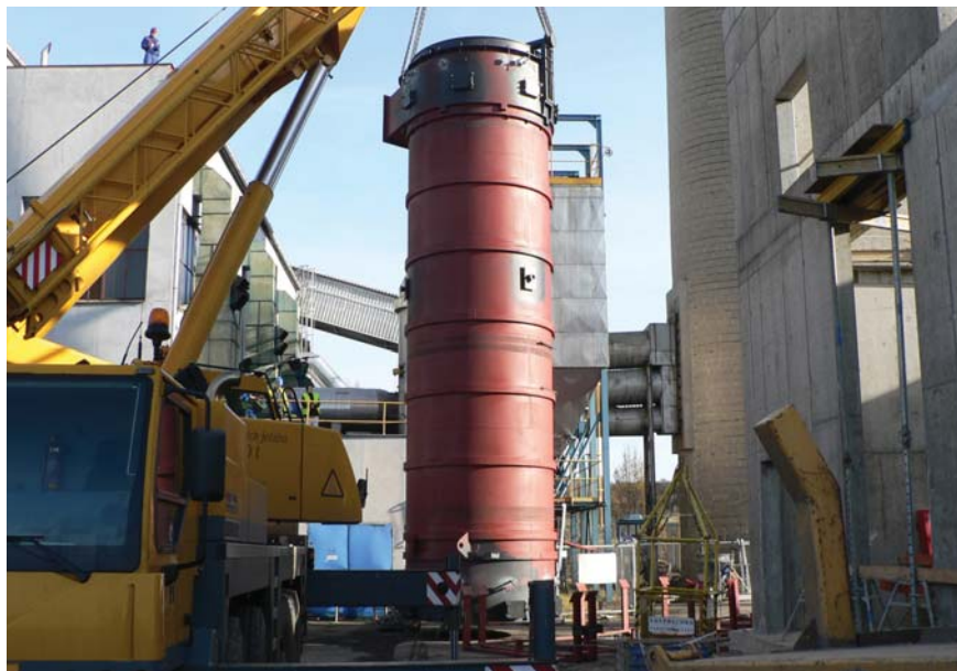
Montáž olejového výměníku kotle
