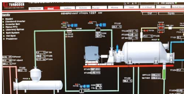
1. července - nájždění technologie
