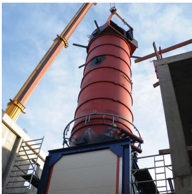
Doprava části technologie (výparník a kondenzátor) - listopad 2009
