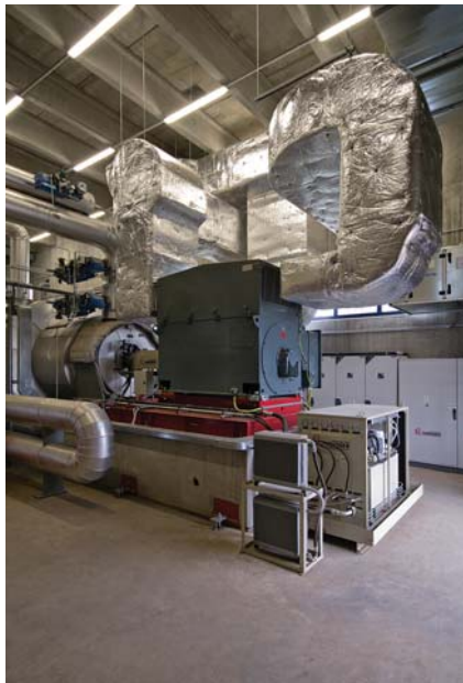
Soustrojí turbíny a generátoru
