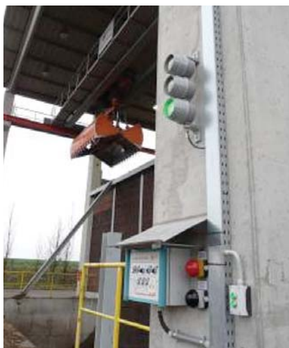
Do prostoru navážení byly instalovány semafovy
