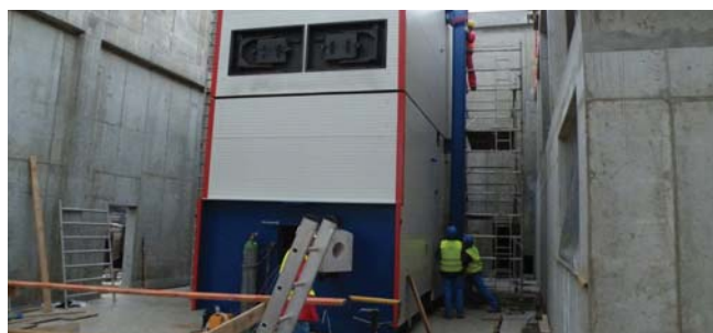
Montáž kotle, topeniště - listopad 2009
