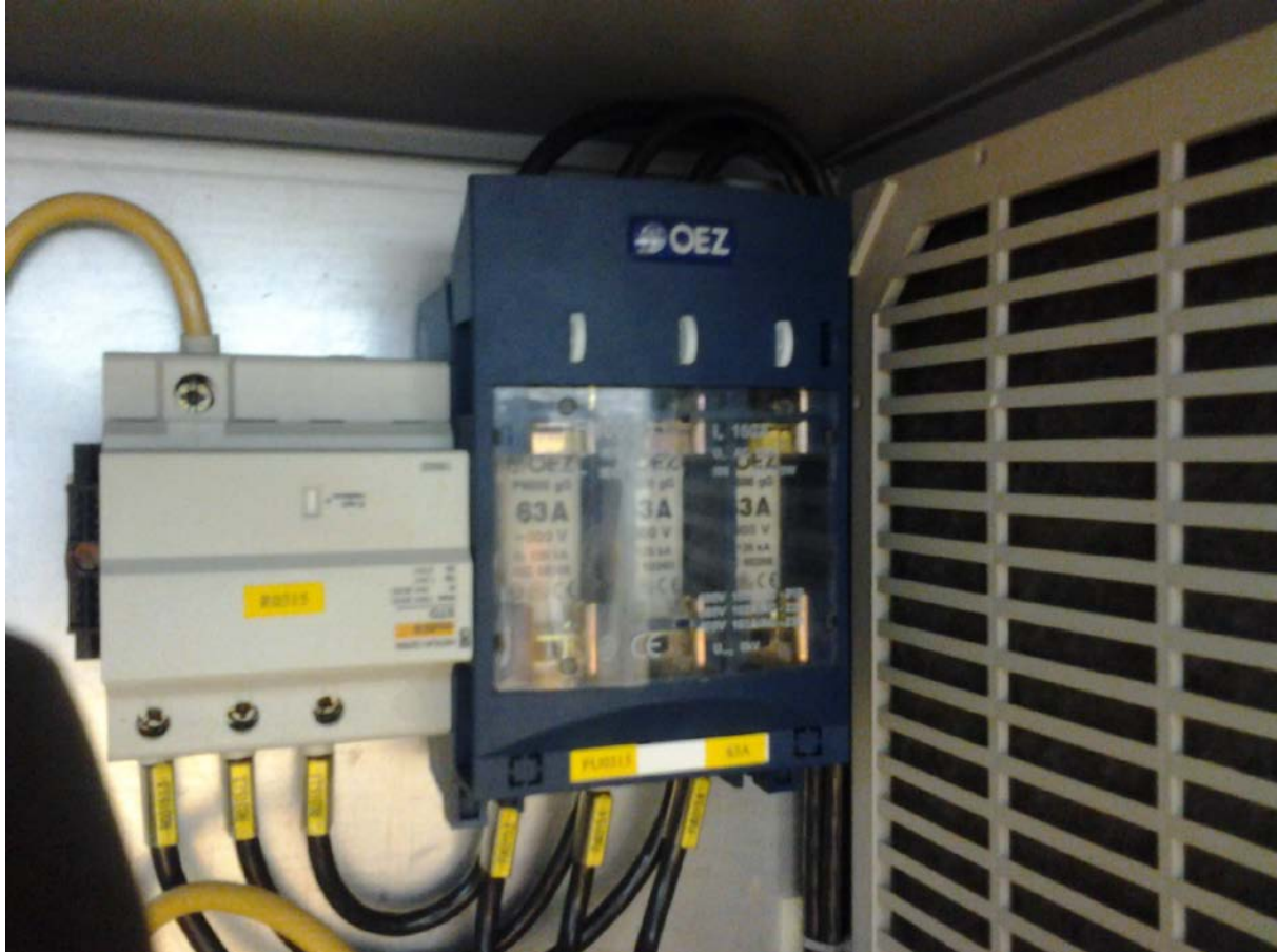
Obr. 1.2-Praktické vnitřní uspořádání pojistek ve výrobním stroji
