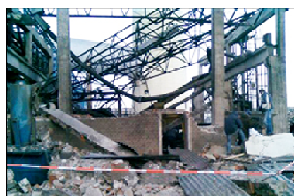
Zgliszcza po wybuchu pyłu węglowego w Elektrowni Dolna Odra - 24.01.10.
