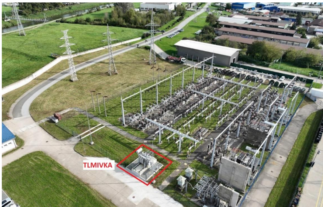
Obrázok 8 Pohľad na rozvodňu R110 kV
